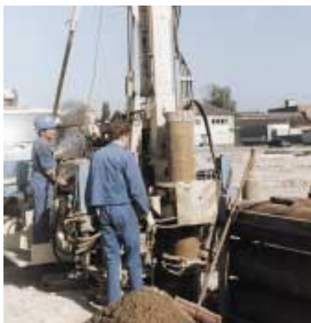
Vertikale Bohrung zum Einsatz der Erdwärmesonde. Foto: Teichmann
