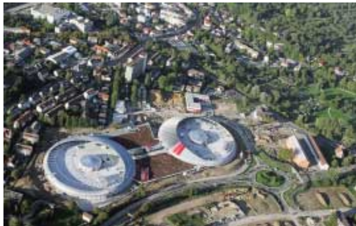
Ein Jahr nach der Grundsteinlegung. Das Fachmarktzentrum als Eckpunkt „der neuen Cité“ kurz vor seiner Eröffnung. Foto: Hertweck
