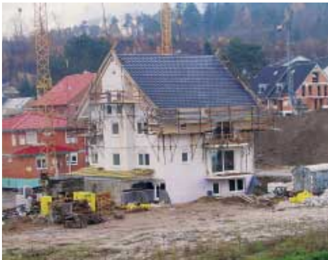
Ein Motor für die regionale Bauwirtschaft ist die Entwicklung der Cité, wie hier im neuen Wohngebiet Paris Foto: AD
