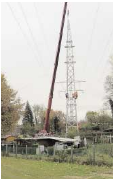
Von diesem Endmast am Salchenbachweg fließt der Strom jetzt durch unterirdisch verlegte 100-kV-Starkstromkabel zum Umspannwerk in der Bauernfeldstraße. Fotos AW/SÖ
